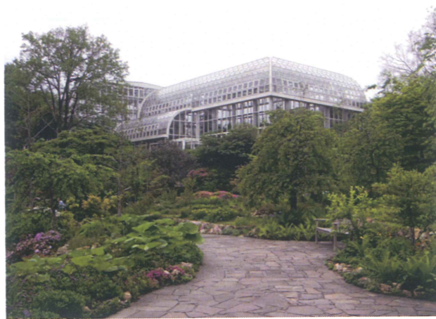
2010年（平成22年）大型温室完成
